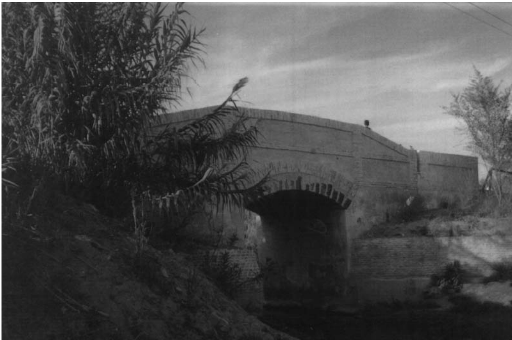
Vistas del antiguo puente romano sobre el río Pudio, restaurado en el siglo XVIII.
