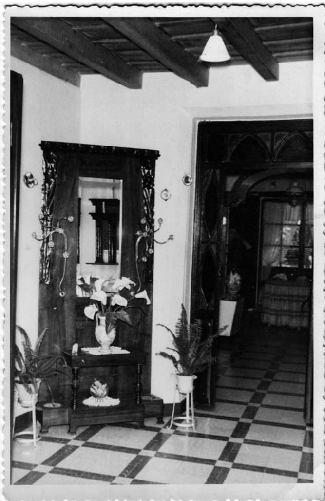
Casa de tres ojos con suelo hidráulico y maderas nobles en el techo. S. XIX.
