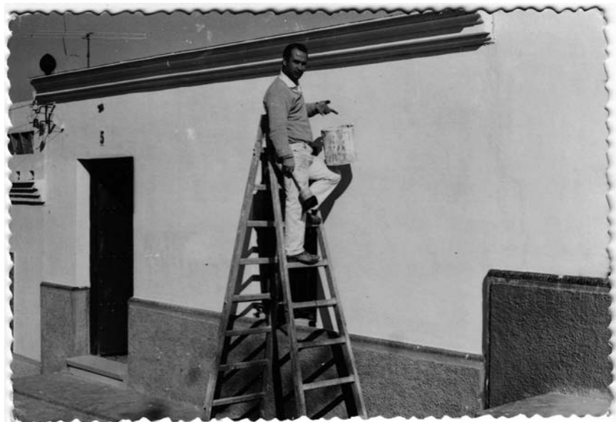
Encalador de brocha gorda. Se llamaban así porque “encalaban” las paredes, es decir, las pintaban con cal viva porque era muy eficaz contra las humedades y las infecciones. La pintura vino mucho después.
